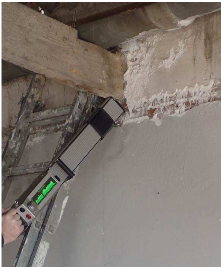
Fotografía 3. Realización de ensayo no destructivo por resistografía para la detección de defectos en la madera antigua.
