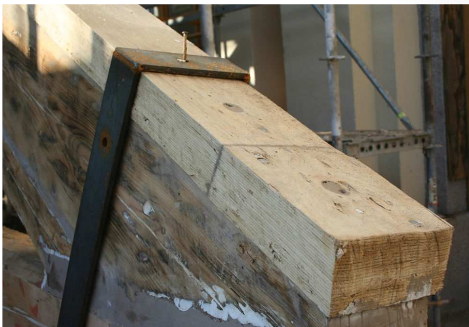
Fotografía 4. Ejemplo de producto de refuerzo (madera microlaminada) en la parte superior de una cercha deteriorada de madera. Fuente: CIS-MADEIRA
